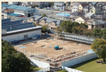
新工場建設予定地
