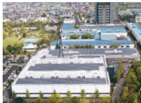
工場棟屋上に設置された太陽光発電パネル
