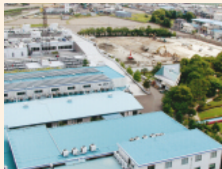
新工場の建設現場（右奥側）
