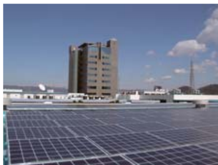
太陽光発電設備
